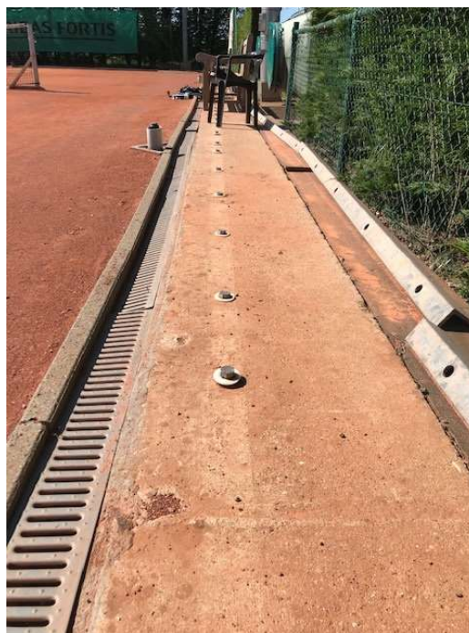
Boulons d'ancrages fixe quand bulle démontée
